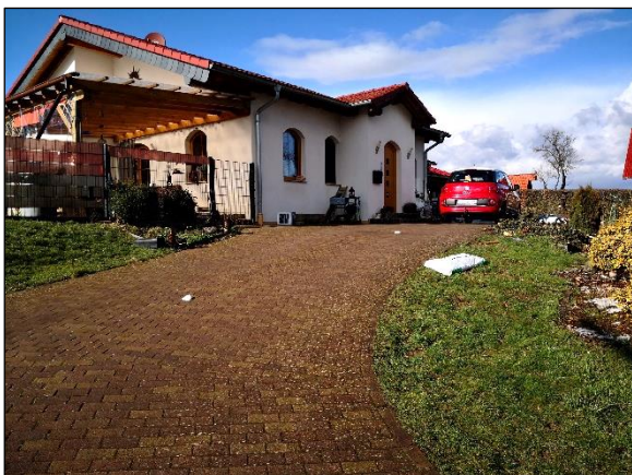
Abb. 14: Wohnbebauung mit Rasenflächen im Bereich des Plangebietes. (eigene Aufnahme, 03/2023)
