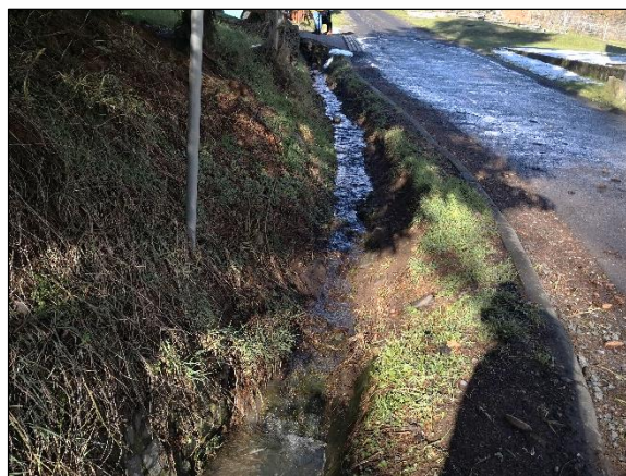
Abb. 19: Wegseitengraben im zentralen Teil des Plangebietes entlang des Häselwegs. (eigene Aufnahme, 03/2023)
